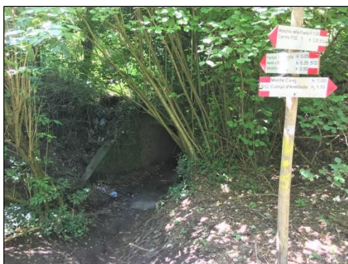
Tunnelen under Via dei Laghi fra den anden side
